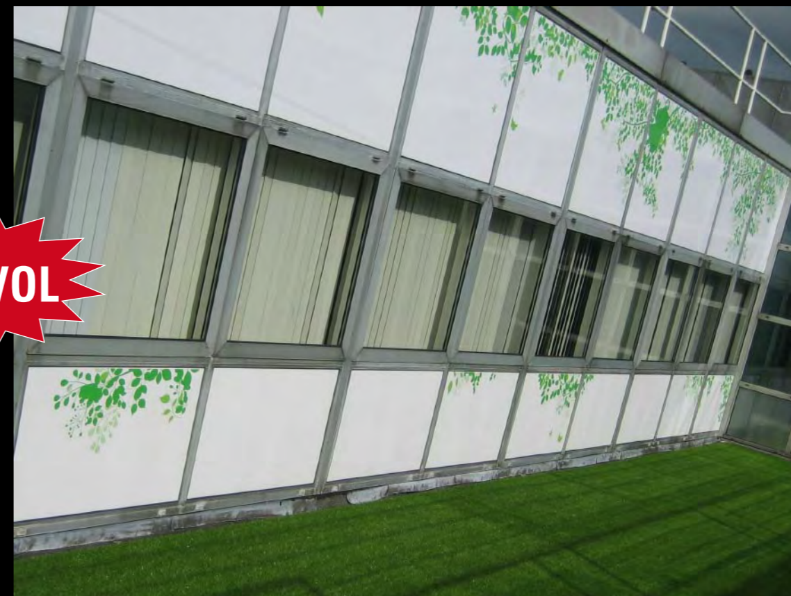
Full-colour printing, aangebracht op kunststof panelen. ▼
